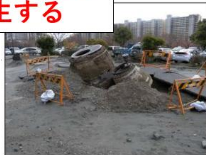
液状化による被害 浦安市（2011年東北地方太平洋沖地震）
